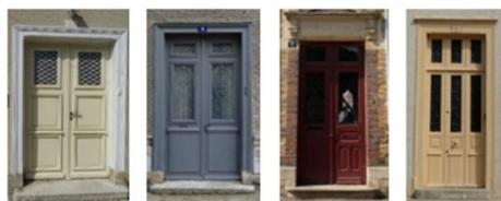
(3) Portes composées de panneaux moulurés et assemblés, la partie supérieure vitrée et protégée par des grilles de défense en fer forgé ou en fonte moulée.
