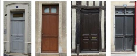
(2) Portes composées de panneaux moulurés et assemblés.
