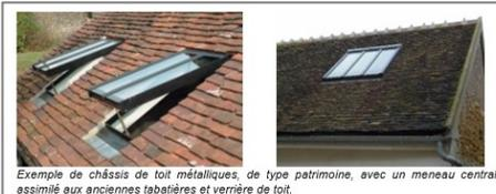
Exemple de châssis de toit métalliques, de type patrimoine, avec un meneau central assimilé aux anciennes tabatières et verrière de toit.
