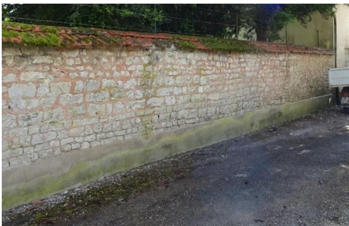
*Photo 6 : Mur en maçonnerie avec un parement de moellons de pierre calcaire et des joints à fleur - Le couverture est en tuiles mécaniques losangées - Ruelle Jean Camus*
