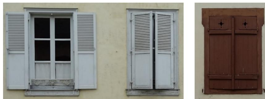
(3) Volets semi-persiennés composés d'un cadre et de lames de bois horizontales dans la partie haute et de panneaux pleins dans la partie basse
