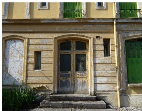
*Exemple de parement bois constitué de larges planches horizontales assemblées (avec un joint imitant les parements pierre à joint creux) et des moulures d'encadrement de baie et des bandeaux.*
