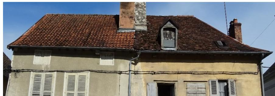
Immeuble avec une couverture, à droite en petite tuile plate et à gauche en tuile mécanique à côte - Grande rue de la Résistance.
