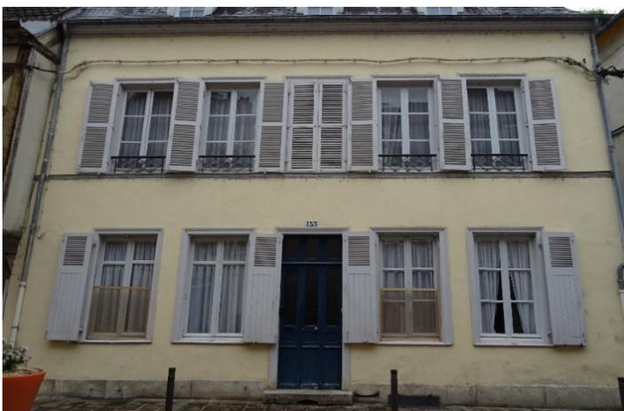
*Façade à pan de bois enduit avec des encadrements de baie moulurés qui assurent la limite entre l'enduit et la menuiserie - 133, Grande rue de la Résistance*
