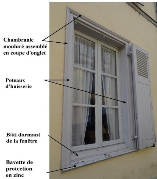
Chambrane moulurée assemblée en coupe d'onglet
