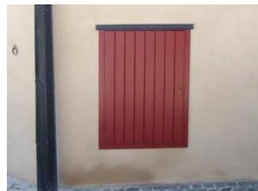
*Coffret technique encastré et fermé par un portillon constitué de lames de bois verticales assemblées*
