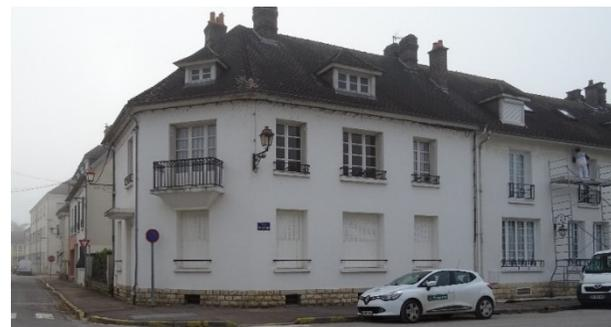
Façade en maçonnerie enduite, encadrements et corniches en béton armé - Immeuble d'angle de la rue Victor Hugo et de la rue Charles Moreau
