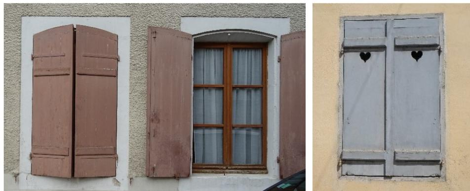
(1) Volets pleins constitués de planches juxtaposées verticalement et tenues par deux barres d'assemblage horizontales. (1) 67, Grande Rue de la Résistance – (2) 14 Grande Rue de la Résistance –
