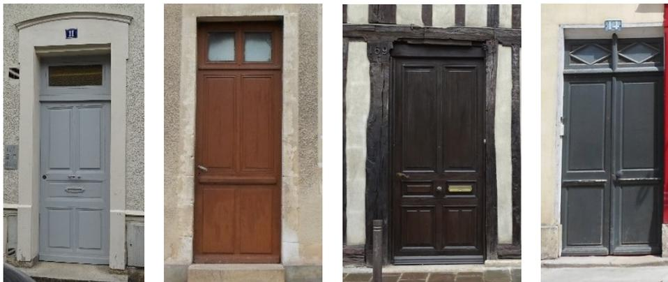
(2) Portes composées de panneaux moulurés et assemblés.
