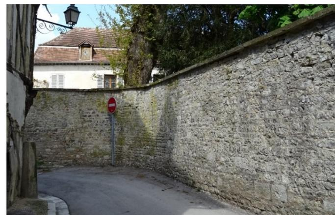
*Photo (3) : Mur en maçonnerie avec un parement de moellons de pierre calcaire et un rejointoyement « à cru » - Le couvrement est en pierre de taille - Rue Cordière*
