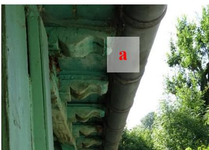
Débord de toiture (a) protégeant le pan de bois de l'eau de pluie, soutenu par des corbeaux en bois (b) - Cour intérieure du 171, Grande Rue de la résistance
