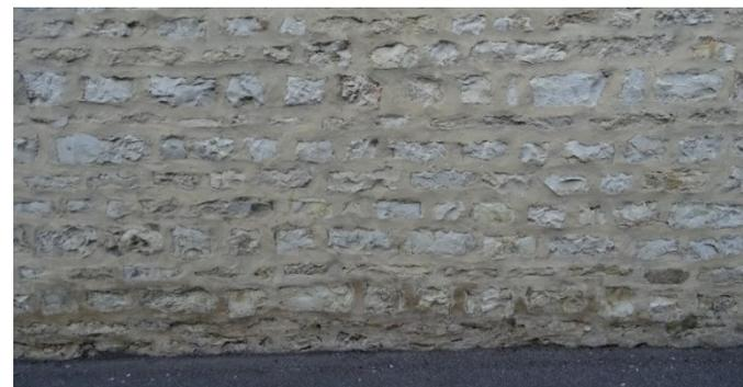
**4AB.14** - Les **rejointoiements** au ciment gris sont interdits qu'ils soient marqués, en creux ou en relief.
