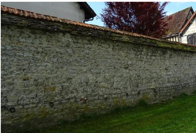
*Photos (1) : Mur en maçonnerie avec un parement de moellons de pierre calcaire et un rejointoyement « à cru » - Le couvrement est en pierre de lave et en tuile mécanique - Allée de la porte de Troyes*
