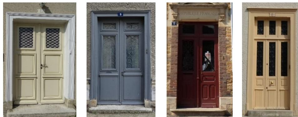
(3) Portes composées de panneaux moulurés et assemblés, la partie supérieure vitrée et protégée par des grilles de défense en fer forgé ou en fonte moulée.
