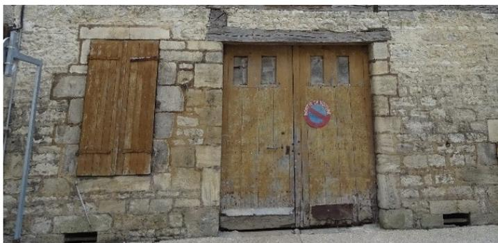
*Façade avec un rez-de-chaussée en maçonnerie de pierre calcaire appareillée avec des joints « au nu de la pierre » - 23, rue Lagesse*
