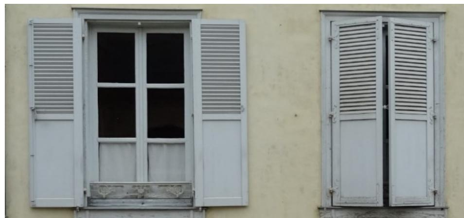
(3) Volets semi-persiennés composés d'un cadre et de lames de bois horizontales dans la partie haute et de panneaux pleins dans la partie basse -1, rue de l'Eglise
