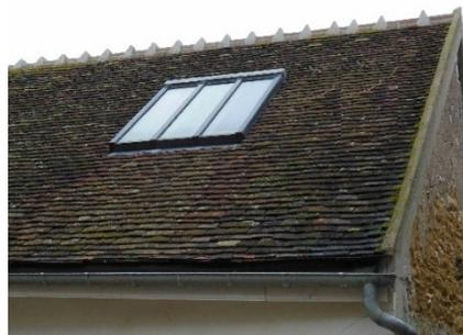
Exemple de châssis de toit métalliques, de type patrimoine, avec un meneau central assimilé aux anciennes tabatières et verrière de toit.
