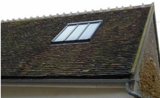
*Exemple de verrière avec un cadre métallique et des meneaux verticaux*
