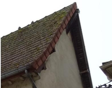
Tuiles de rive et tuiles faitières à recouvrement par un bourrelet
