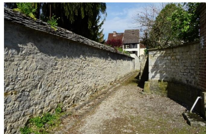
*Photo (4) Mur en maçonnerie avec un parement de moellons de pierre calcaire et un enduit à pierre vue- Le couvrement est en pierre de lave - Ruelle Jean Coin*
