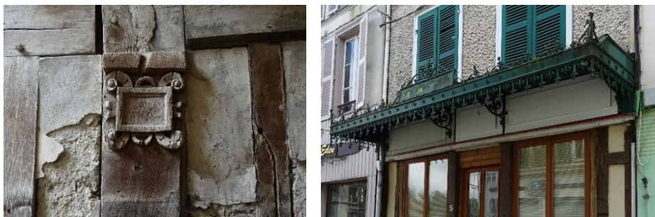
Détail médaillon sculptés, ruelle de la Poste et marquise en ferronnerie 5, rue de la République
